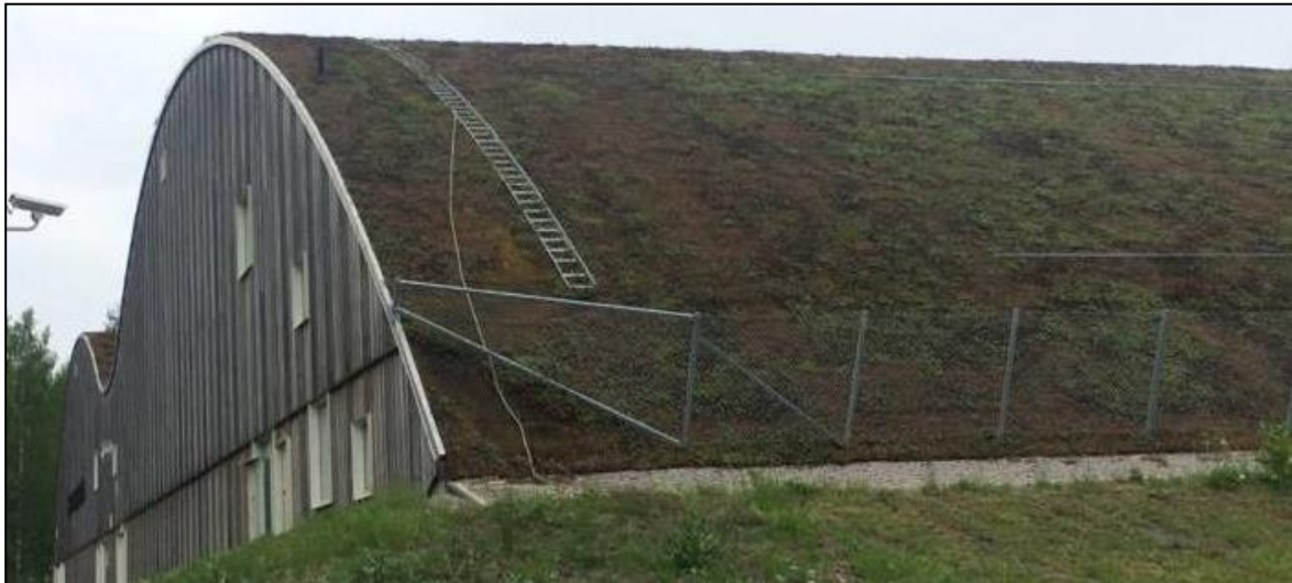
Figur 11. Grönt sedumtak på SEB USIF arena, Uppsala. Foto: E. Hagström, Structor Uppsala AB (2016).
