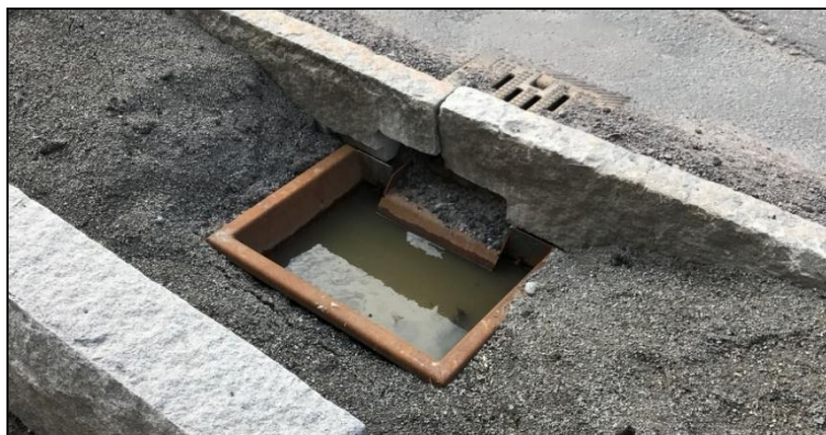
Figur 15. Anläggning av inloppsbrunn till planteringsyta med gallerbetäckning och spridningskärl. Foto: A. Thorsell Structor Uppsala AB (2019).
